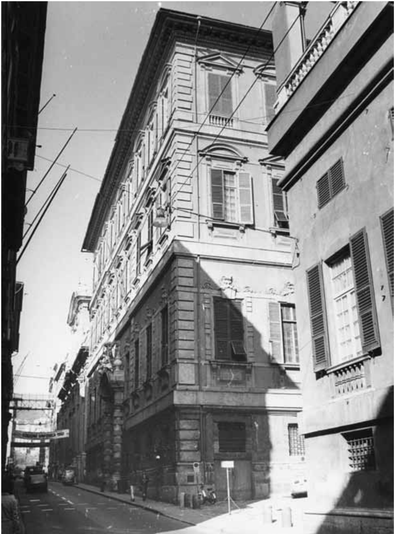
110. Genua, Kolleg, Außenbau.
